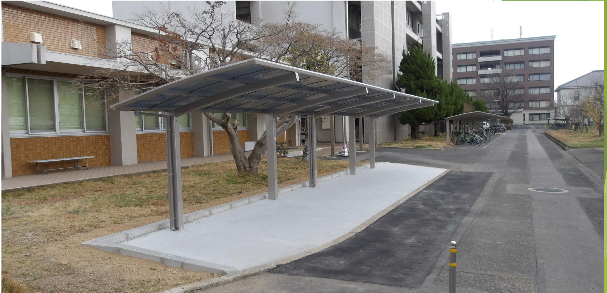
薬学部本館外部自転車置場増設
